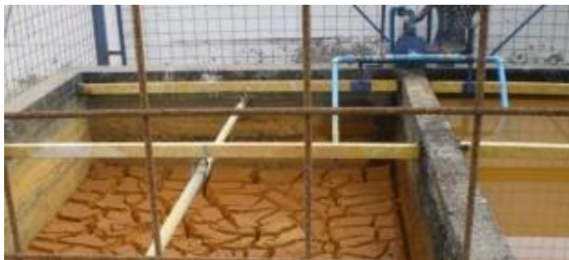
Imagen 9: Cancha de secado de lodos PTAP Pisagua
