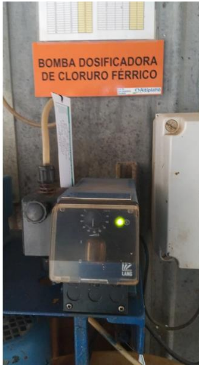
Imagen 4: Bomba dosificadora de cloruro férrico (29-03-2022)
