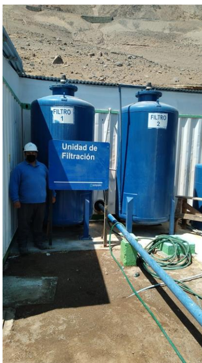
Imagen 6: Sistema de filtración PTAP Pisagua
