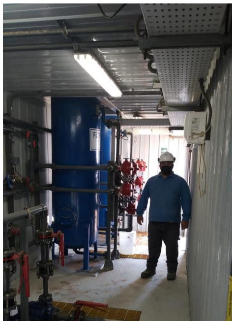
Imagen 8: Filtros en paralelo GEH
