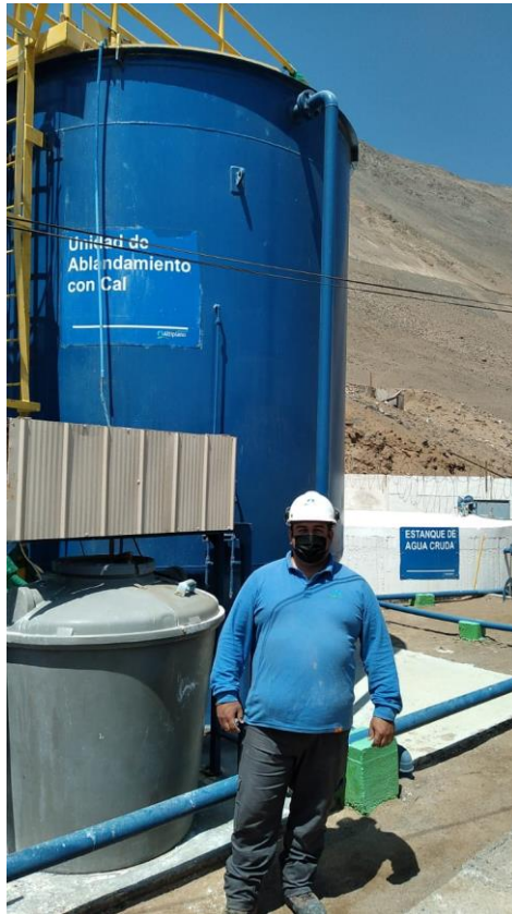
Imagen 5: Reactor Floco-Decantador PTAP Pisagua
